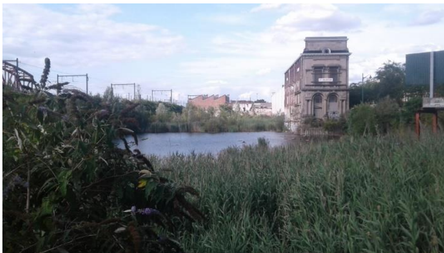
Vue actuelle du marais vers le bâtiment Métropole (© photo CRMS, octobre 2024)
